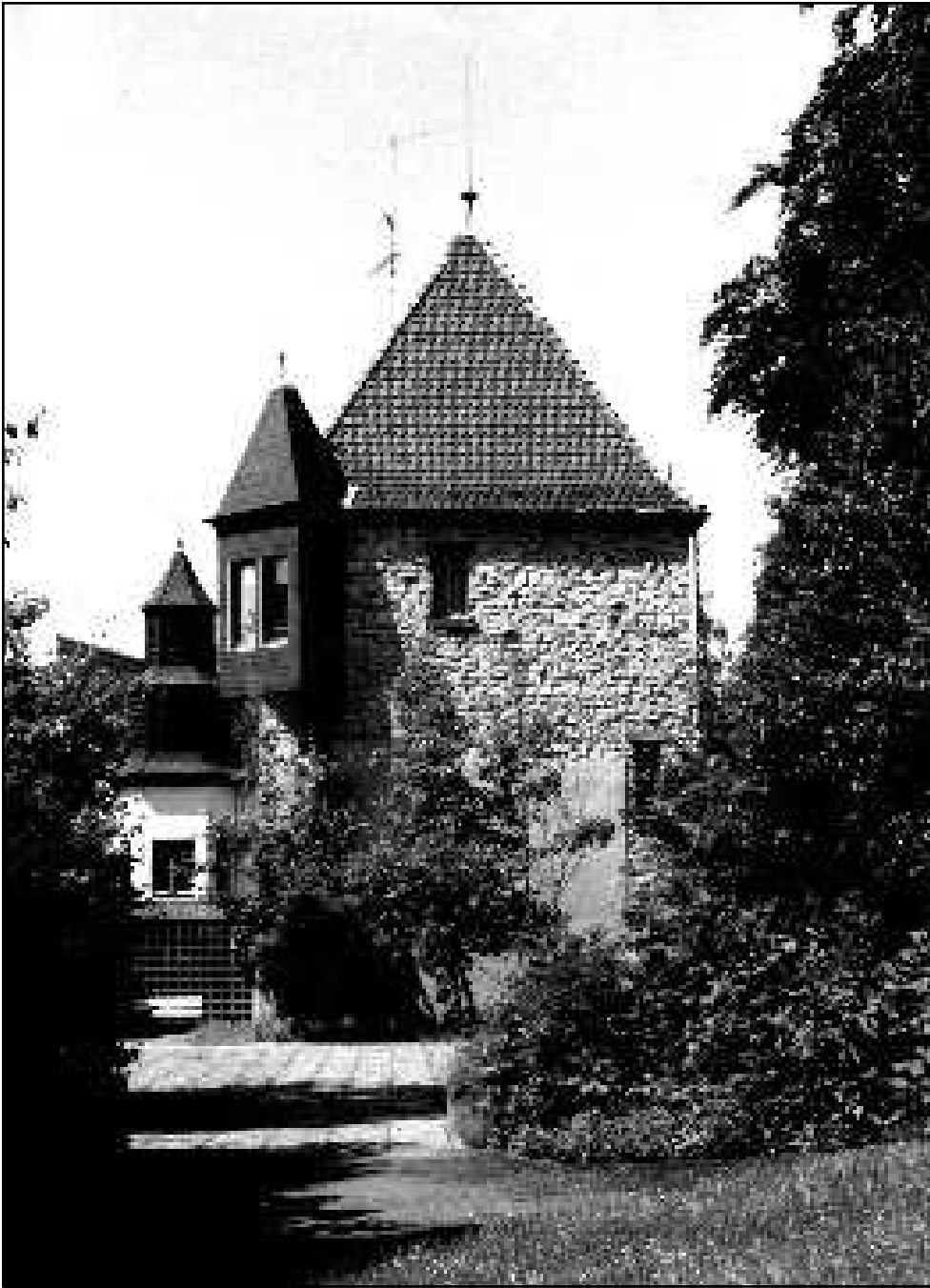
Historischer alter Turm im Klostergarten wurde im Jahre 2002 vor dem Abriss bewahrt.
